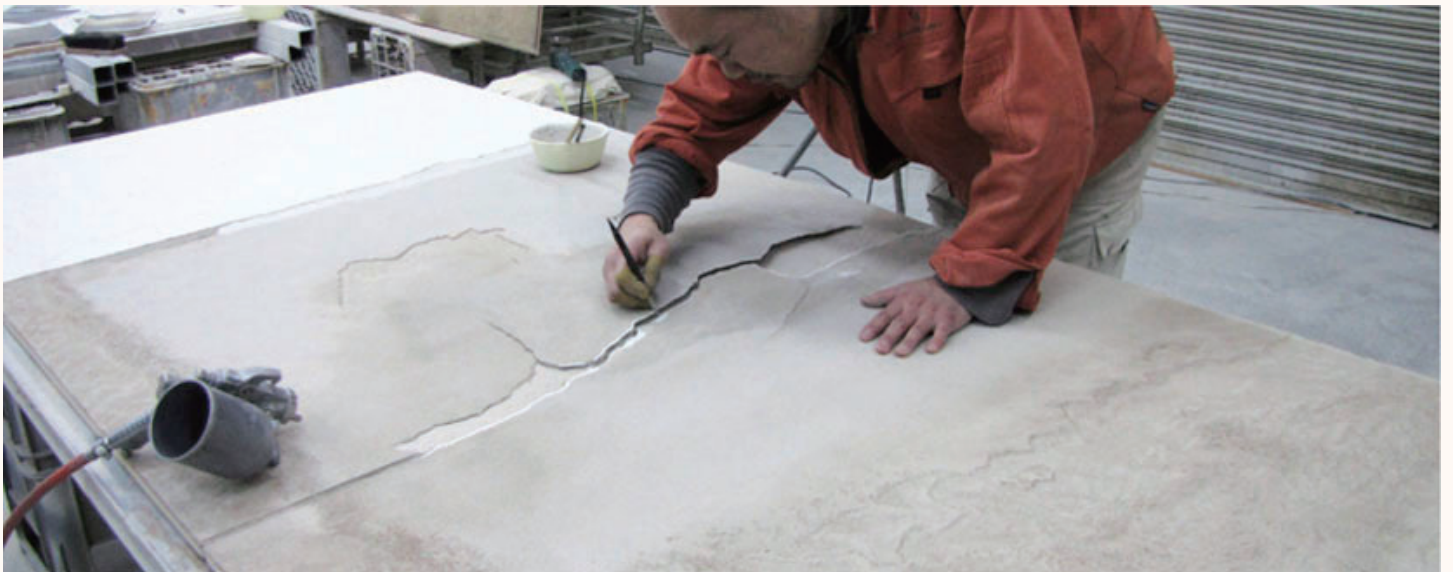
浮き上がった漆喰のエッジの加工 Processing raised plaster edges
